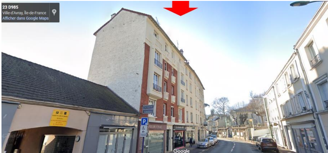
Ci-dessus : groupe de 3 immeubles, en rupture totale avec les hauteurs moyennes du centre-ville.
