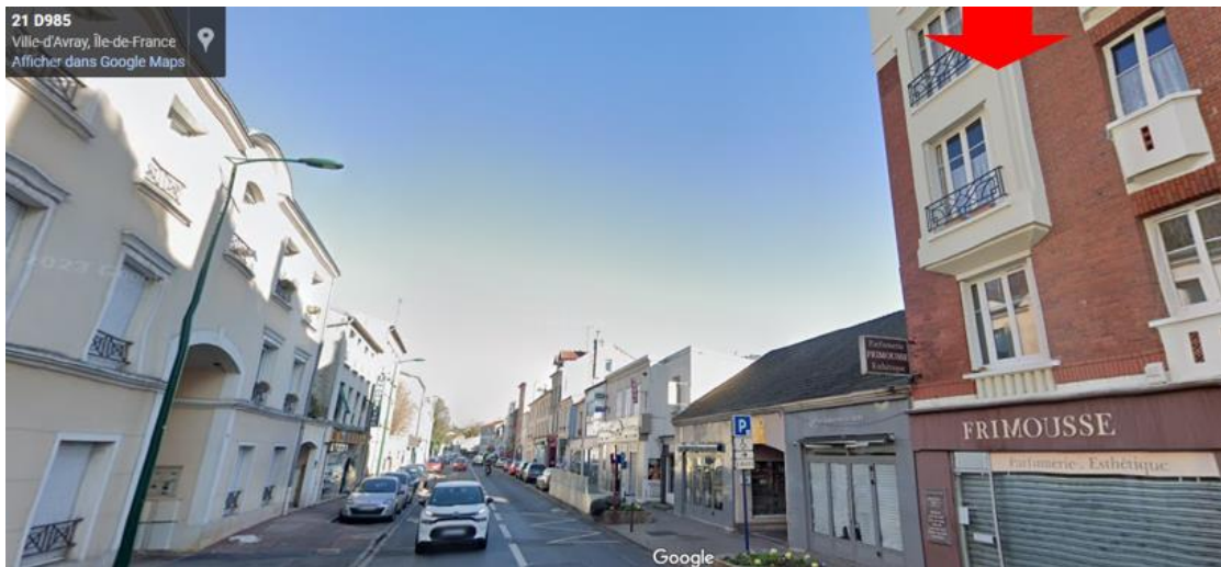
Ci-dessus : immeuble à droite en rupture totale avec les hauteurs moyennes du centre-ville.
